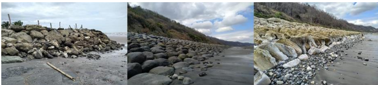
Figura 4. En la zona 1 hasta la zona 4 donde se observa escolleras adherentes y espigones perpendiculares al acantilado compuesto de material rocoso tipo basalto y lutita.
