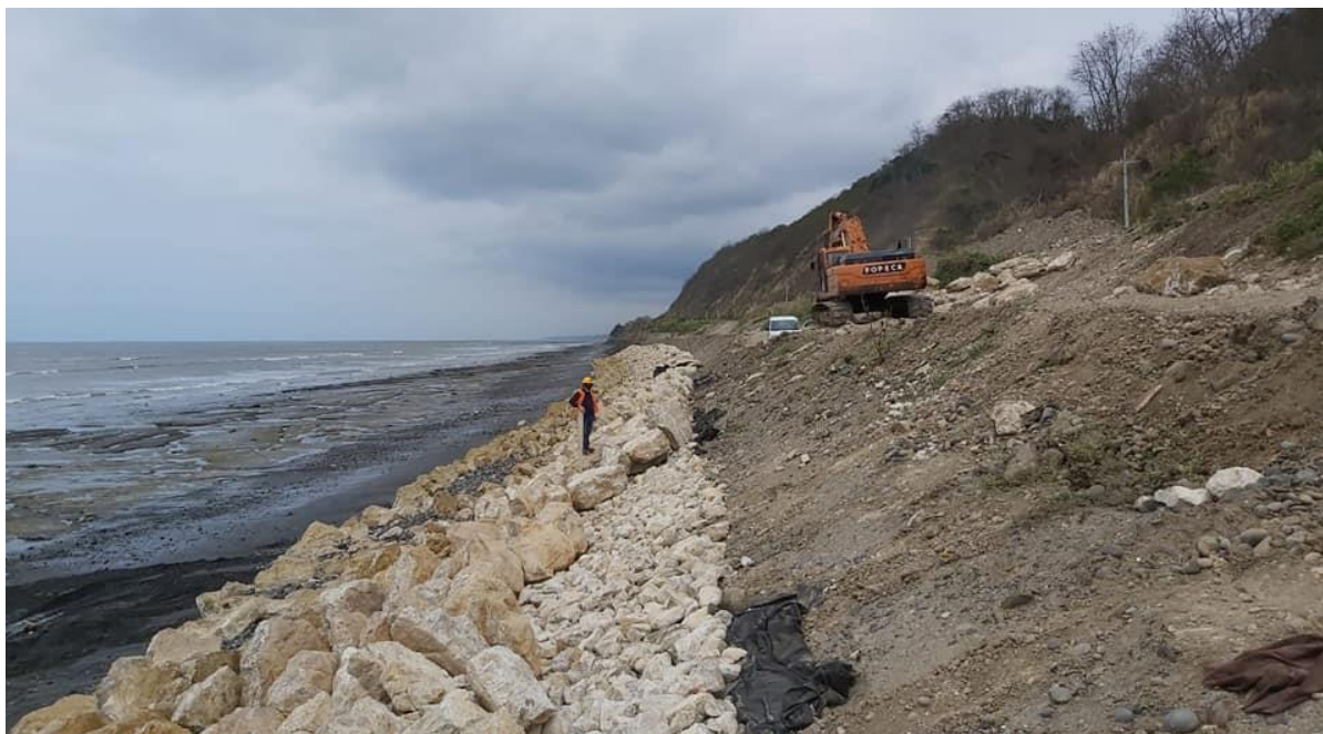
Foto 3: Riesgos Naturales – Escolleras para detener el oleaje
